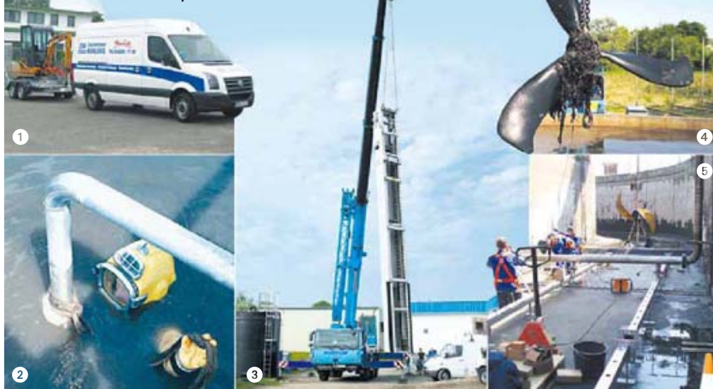
Mit eigener Technik (Bild 1) und noch spezialisierteren Fachkräften (siehe Taucher Bild 2) sowie großem Gerät wie beim Einsatz am Kühlungsborner Hauptpumpwerk (3) packt der Zweckverband Kühlung seine Instandhaltung an. Große Rührwerke (4) werden ebenso erneuert wie ganze Reinigungsbecken im Klärwerk (5).
