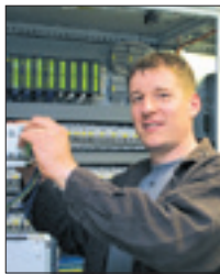
Jürgen Möller an einem der Schaltschränke auf der Kläranlage in Bad Doberan.
