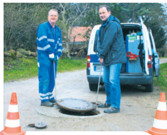
Auch als Meisterbereichsleiter kennt er die praktischen Handgriffe – hier überprüft Peter Klimas (re.) mit Mitarbeiter Lothar Brott den Schacht einer Druckrohrleitung.
