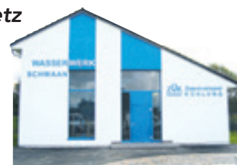
Fertiggestellt 2005: das neue Wasserwerk in Schwaan.
