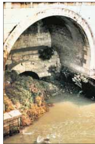
Teile der Abwasserleitung Cloaca Maxima in Rom existieren heute noch.
