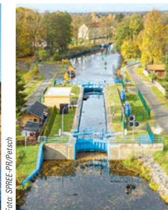
Der fast 100 Jahre ungenutzte Kanalabschnitt des Langen Trödels zwischen Liebenwalde (im Bild) und Zerpenschleuse wurde von 2013 bis 2015 einschließlich des Neubaus einer Schleusenanlage ②, zweier Klappbrücken und einer Hubbrücke wiederhergestellt.
