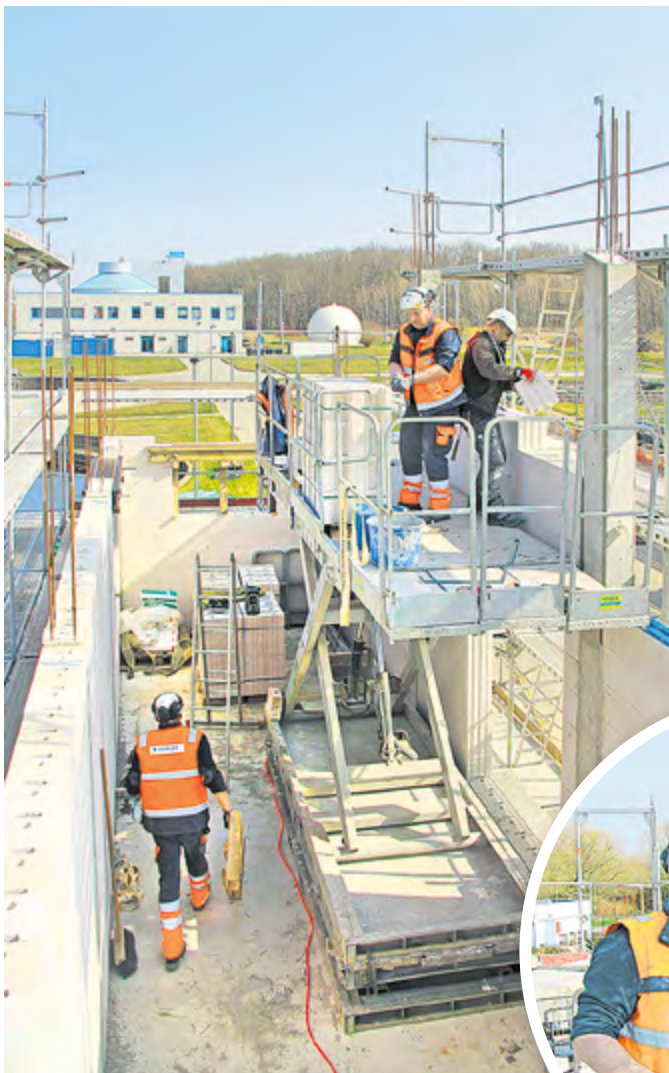
▲ Stein auf Stein hieß es im März auf der Baustelle. Die Außenhüllen des neuen Gebäudes entstanden.
